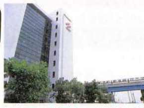
ポートライナーが走るコナミ本社ビル付近
